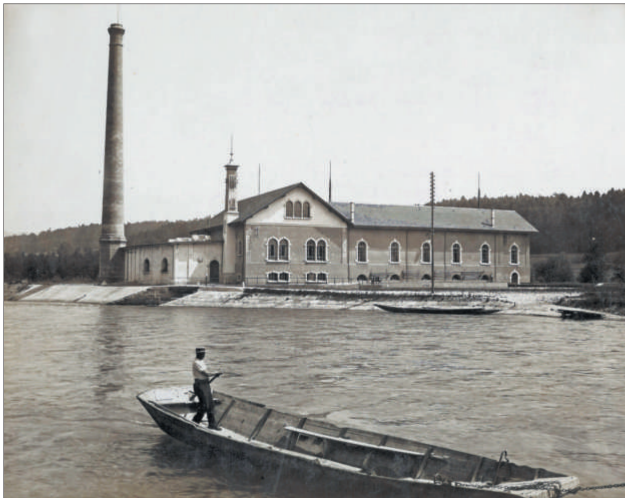
Die Zentrale des Kraftwerks Rathausen um 1900. Vorne der Fährmann, der damals dort tätig war.
