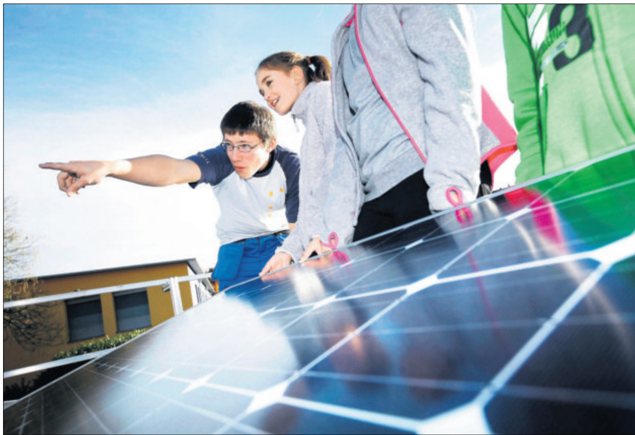
Jetzt kommen die Solarpanels aufs Dach des Kindergartens: Schülerin Rafaela erhält Instruktionen von einem Mitarbeiter der Ebikoner Energiefirma BE-Netz.
